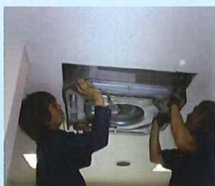
業務用エアコン交換
