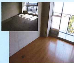
フローリング交換工事
