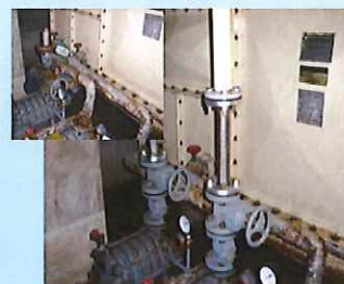
給水管交換工事
