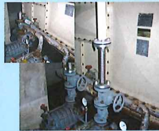
給水管交換工事
