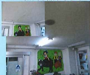
LED照明器具取付
