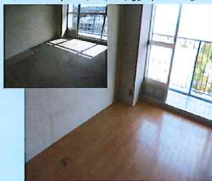
フローリング交換工事
