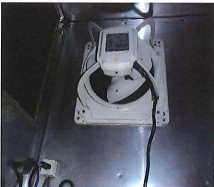
換気扇プロペラ「清掃後」
