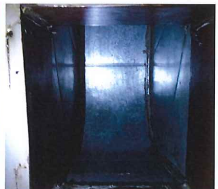
ダクト「清掃後」
