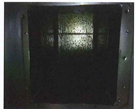
ダクト「清掃前」
