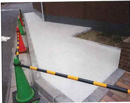
コンクリート舗装
