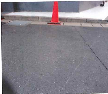
アスファルトに横断歩道 施工前
