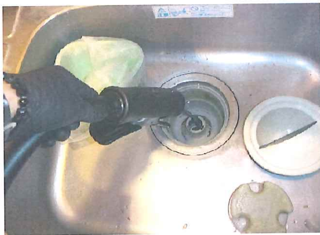
電動トローラーにより作業中
