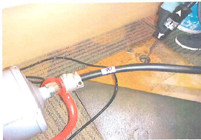
電動トローラーにより作業中
