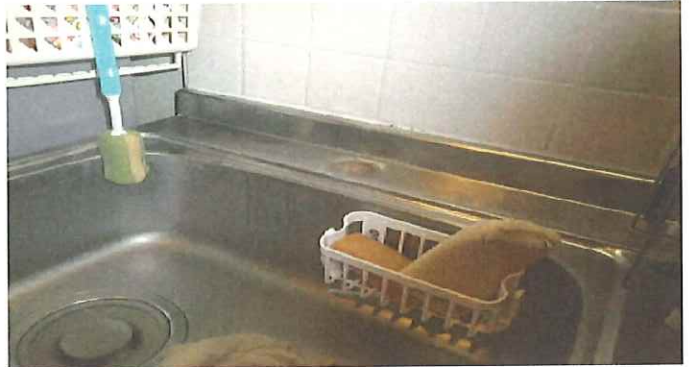
水栓取り外し
